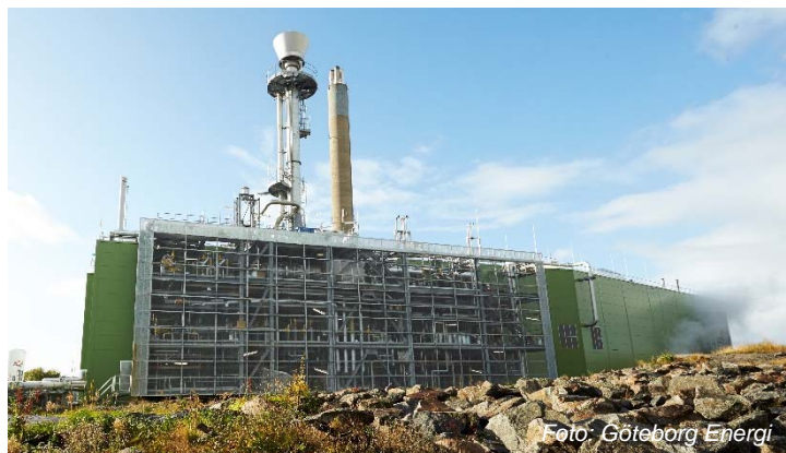
GoBiGas - Göteborg Energis biogasanläggning
